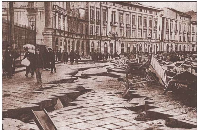
Трещины и просадка на набережной Мессины [6].
